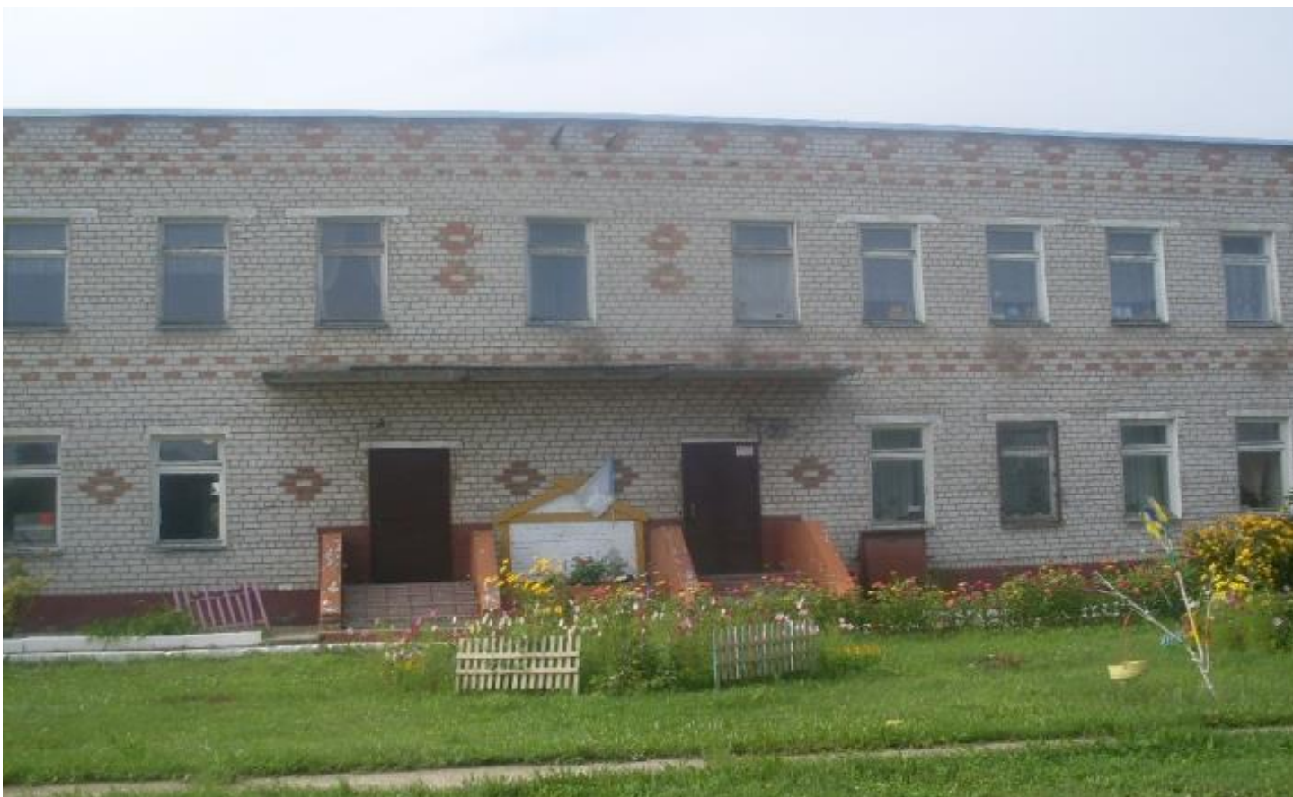
Фото № 20 Здание; Фото № 5 Входная площадка
