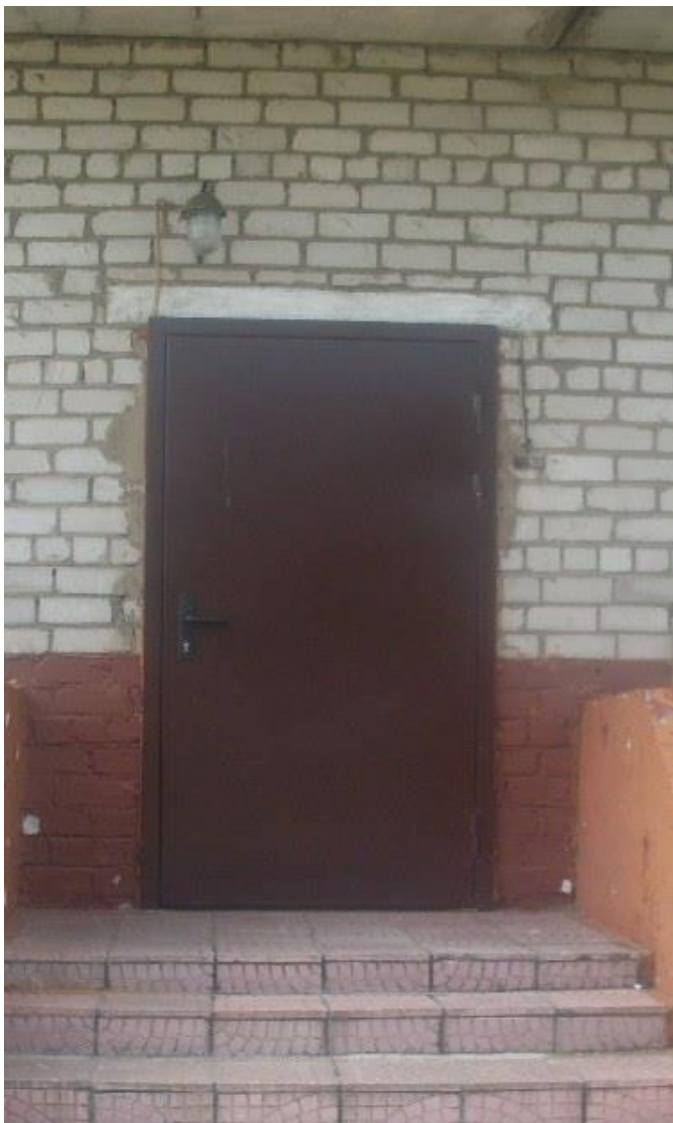
Фото №4 Лестница; Фото №6 Дверь входная наружная
